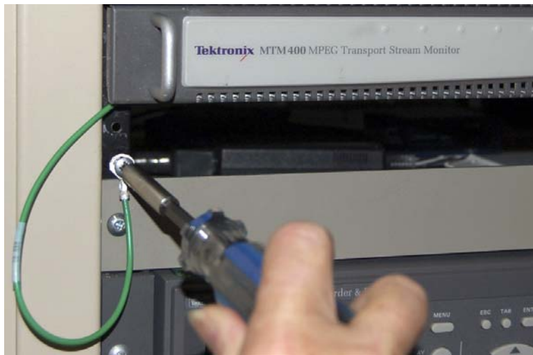
図 B-5: ラック・フレームへのグラウンド・ストラップの取り付け
