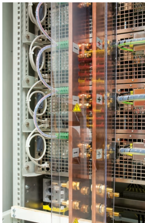
Borne du bus DC / DC bus terminal
