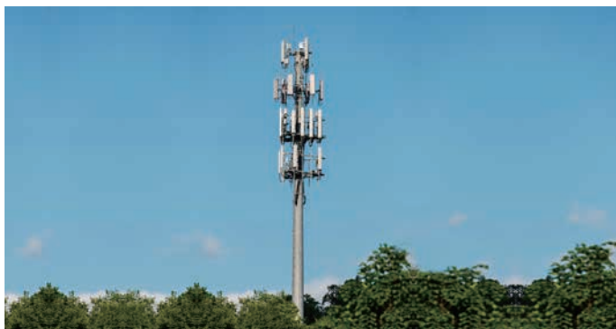
図12. 混在するアンテナ・システムを持った携帯基地局の例
